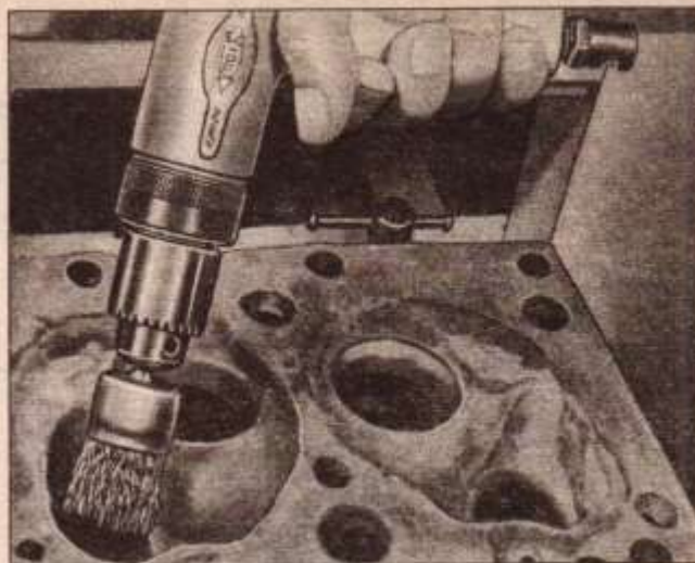
Фиг. К.23-1. Почистване на повърхност с механизирани телена четка
